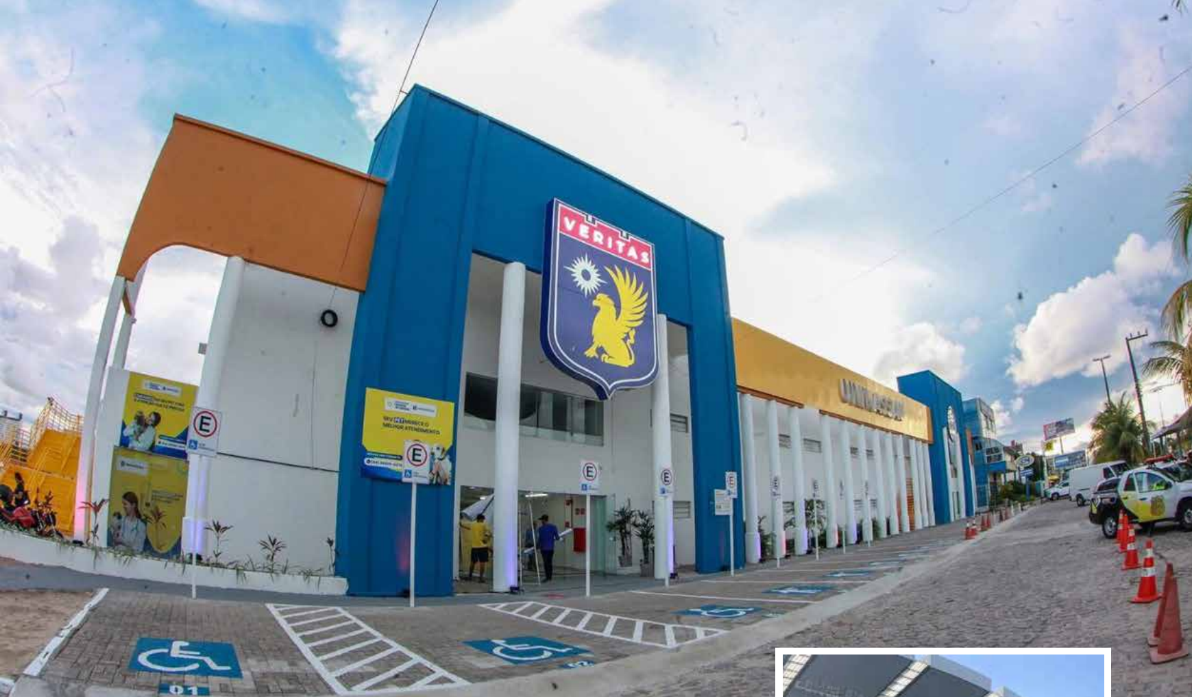
UNIDADE DA UNINASSAU EM CAPIM MACIO - NATAL
