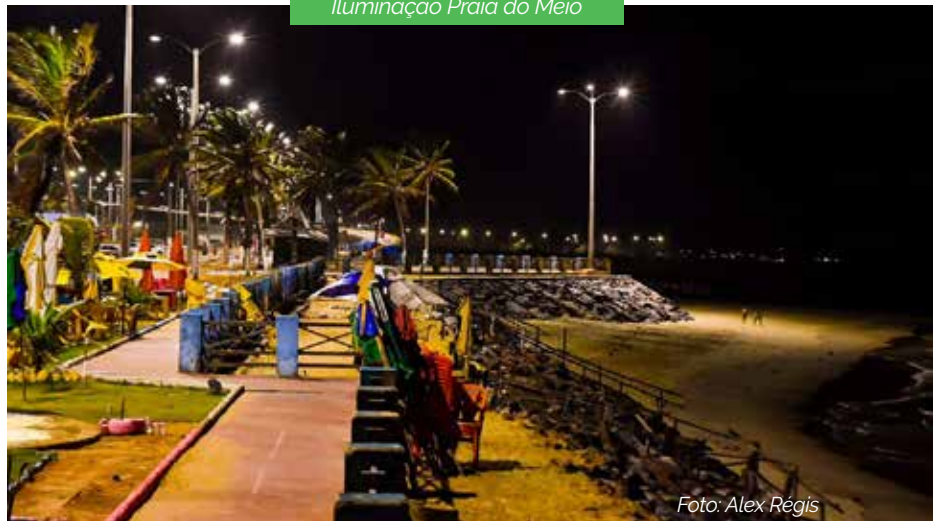
Iluminação Praia do Meio
